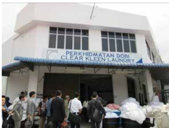
<写真① 工場正面>
