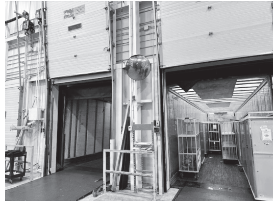
(積込：ドックシェルター)
