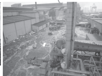
3mの津波: 液化酸素製造工場
